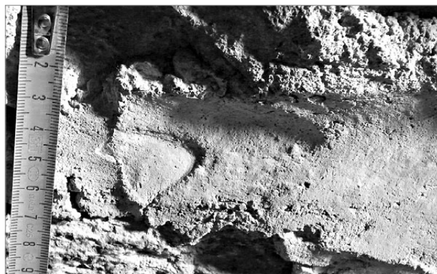
fig. 11 – Tassullo, castel Valer. Particolare di impronta di cazzuola rinvenuta sul paramento interno ovest del mastio (periodo I; foto arch. Giorgia Gentilini).
