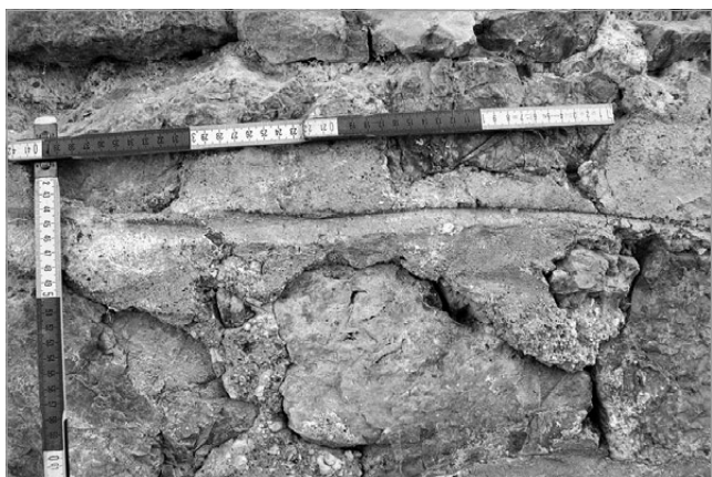
fig. 5 – Besenello, castel Beseno. Particolare della malta di finitura sul paramento interno ovest della casa-torre di periodo I.
