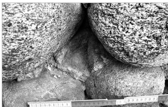
fig. 12 – Cagnò, castello. Particolare di impronta di cazzuola rinvenuta sul paramento esterno ovest del corpo abitativo.
