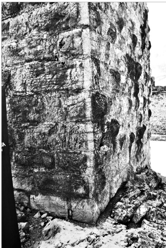
fig. 10 – Drena, castello. Particolare della fondazione del mastio (lato nord, periodo II).
