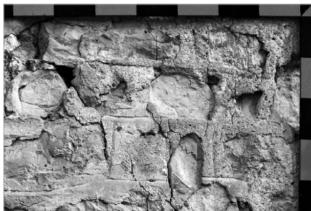
fig. 6 – Mezzocorona, castel San Gottardo. Particolare della malta di finitura sui paramenti interni del mastio di periodo I.
