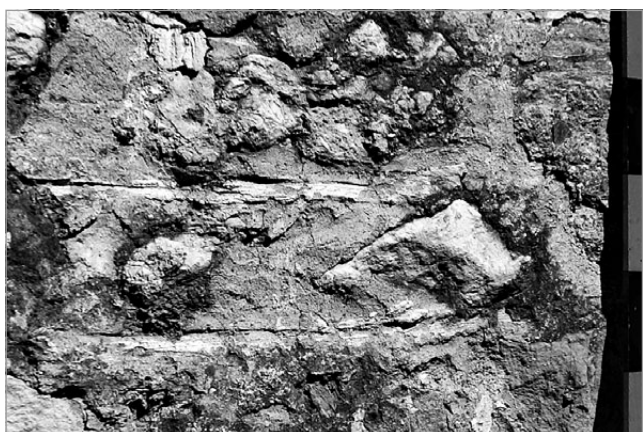
fig. 7 – Ivano-Fracena, castel Ivano. Particolare della malta di finitura sul paramento esterno ovest del mastio (periodo I).
