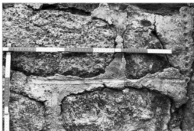
fig. 8 – Pieve di Bono, castel Romano. Particolare della malta di finitura in prossimità dell'ingresso al corpo di fabbrica nord-est del nucleo fortificato sommitale (paramento interno sud-est, periodo II).
