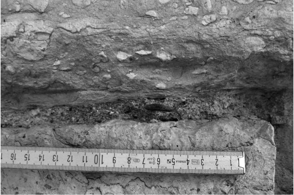
4. Torre di piazza: tecnica muraria del periodo I, particolare metrico della malta di finitura
