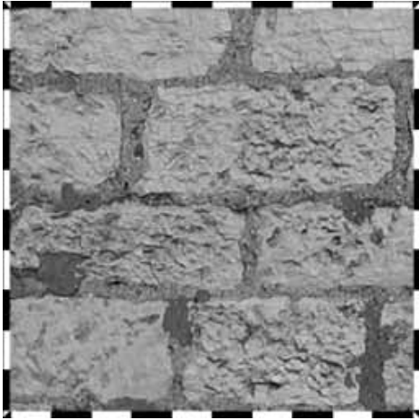
6. Torre di piazza: tecnica muraria del periodo II, campione metrico di muratura sul lato nord
