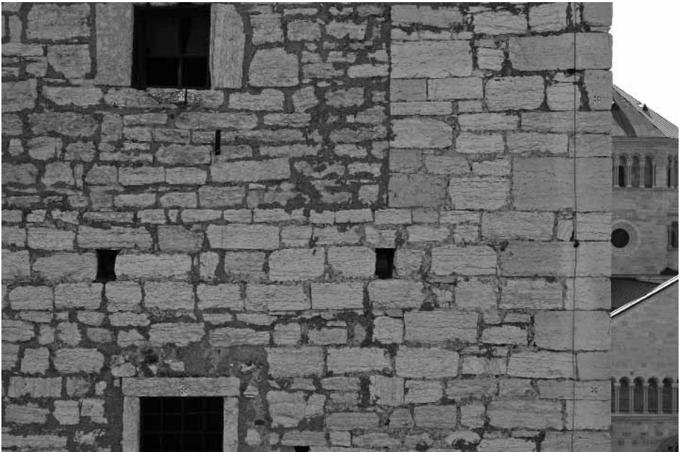
5. Torre di piazza: tecnica muraria del periodo II, porzione paramento esterno nord con particolare del rialzo murario della merlatura
