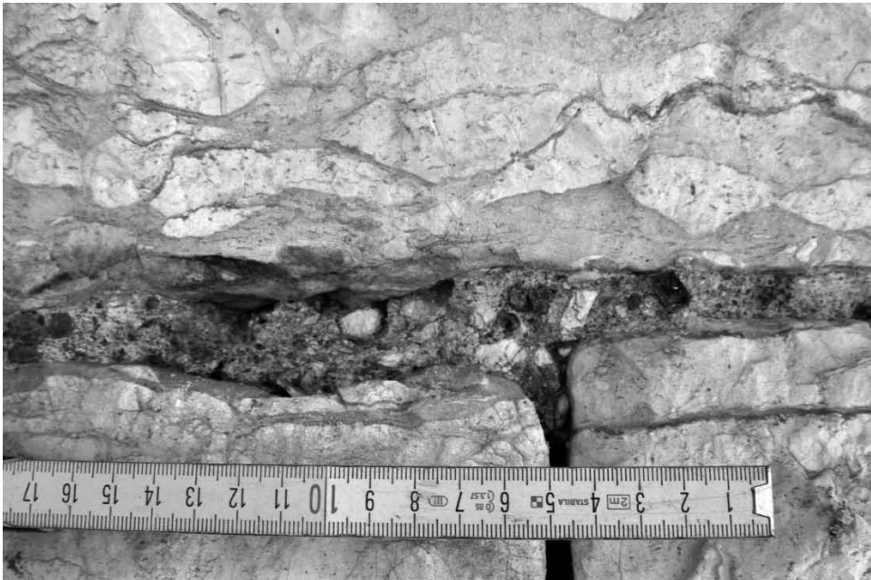
8. Torre di piazza: tecnica muraria del periodo II, particolare metrico della malta di finitura
