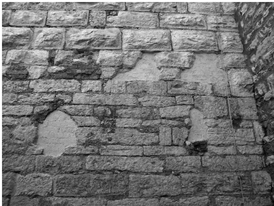
1. Torre di piazza: tecnica muraria del periodo I, porzione paramento esterno ovest
