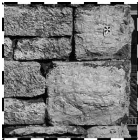
3. Torre di piazza: tecnica muraria del periodo I, campione metrico della muratura in corrispondenza dell'angolata sud-ovest
