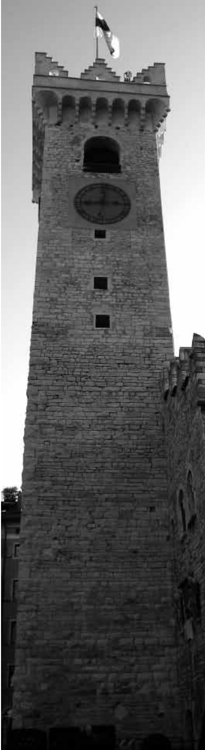
14. Torre di piazza: prospetto esterno ovest al termine del cantiere di restauro
