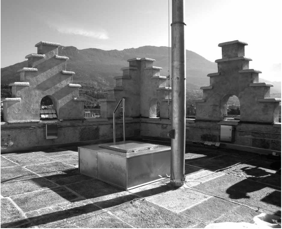
15. Torre di piazza: assetto del piano di copertura a due falde al dodicesimo livello
