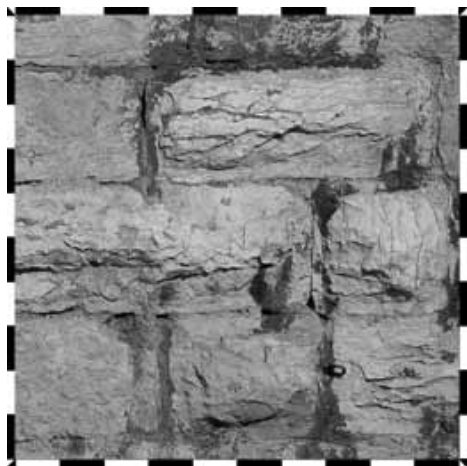
2. Torre di piazza: tecnica muraria del periodo I, campione metrico di muratura sul lato ovest
