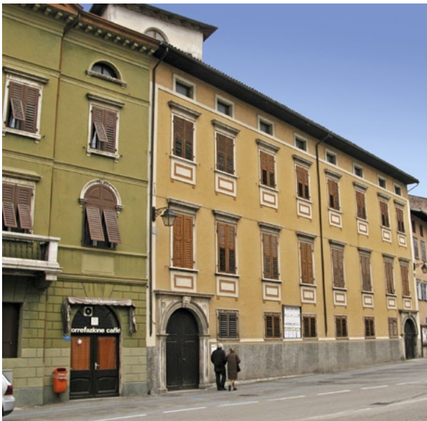
fig. 1 – Prospetto principale di palazzo de Maffei sull’antica strada imperiale, ora via Matteotti.
