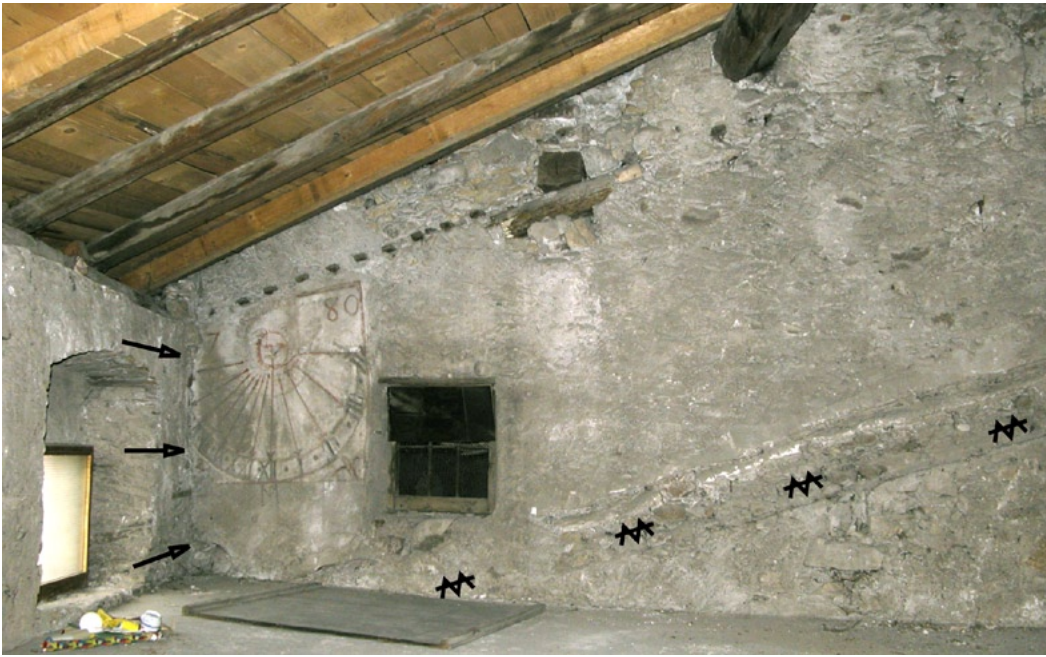
fig. 25 – Dettaglio traccia muraria della copertura precedente con l'addossamento della sopraelevazione della facciata alla meridiana datata 1780.
