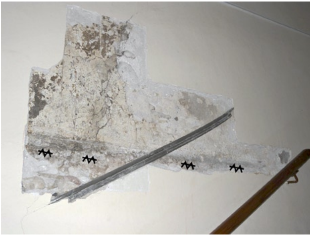
fig. 12 – Sondaggio 45, impronta del solaio ligneo precedente.
