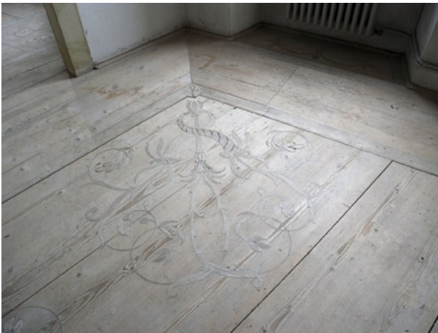
fig. 22 – Dettaglio pavimento intarsiato piano secondo ambiente II° 12.
