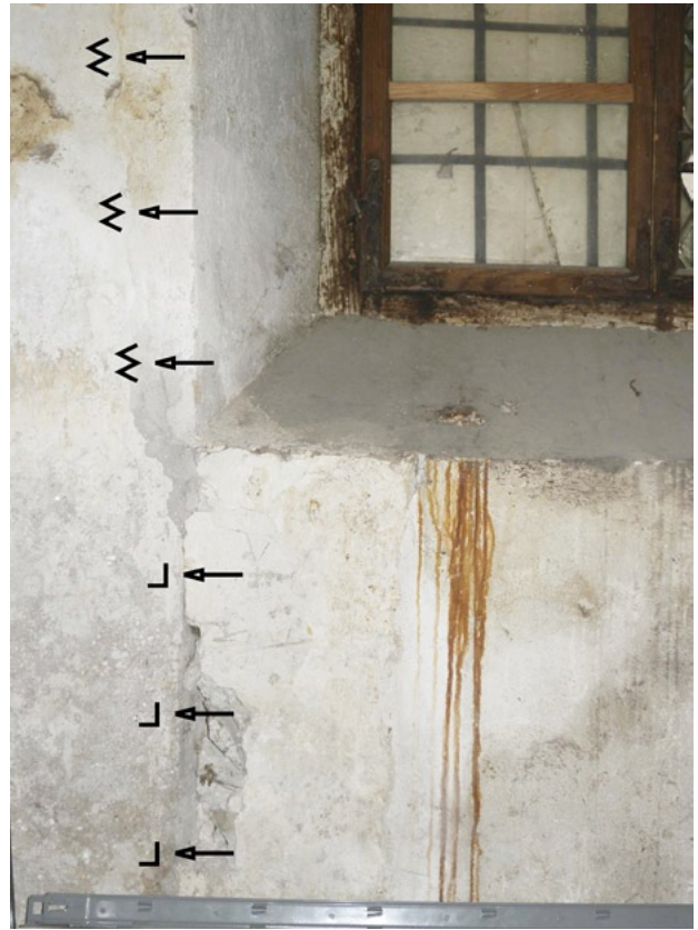
fig. 6 – Sondaggio 19, particolare del piedritto interno del portale d'ingresso.
