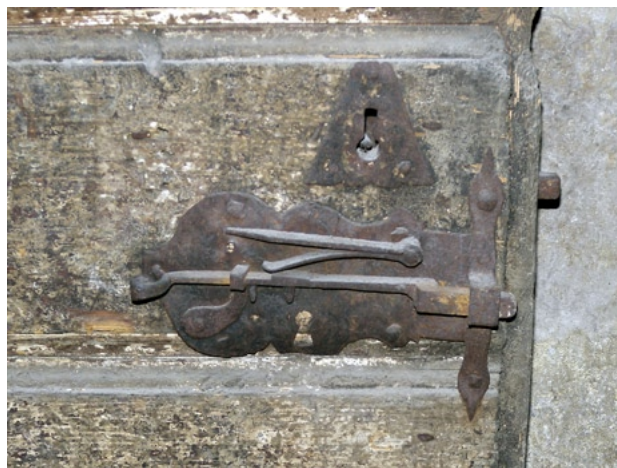
fig. 11 – Ambiente T04, particolare della serratura in ferro del serramento.
