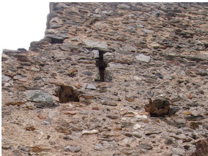
Fig. 4. Castello Vecchio, paramento esterno nord del vano H. Particolare dell'archibugiera in muratura e dei fori di alloggiamento, in rottura, pertinenti alle travi degli orizzontamenti interni al vano 1 (foto dell'Autrice).
