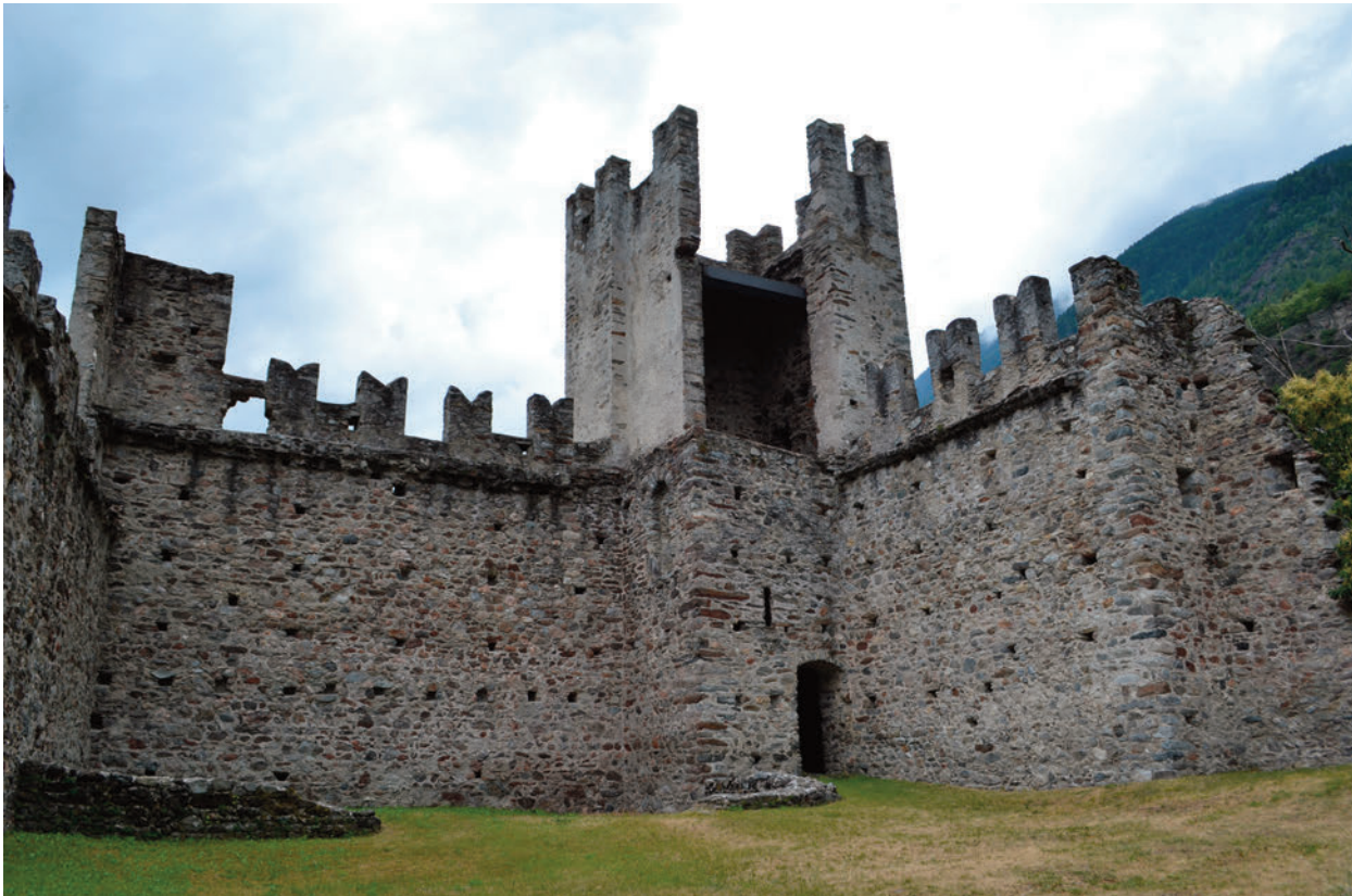
Fig. 7. Castello Nuovo, vista generale da nord-est della corte interna del circuito difensivo di periodo I, fase I. Si notino gli elementi architettonici (porta in quota e feritoia) coevi alla torre sud-ovest (foto I. Zamboni).
