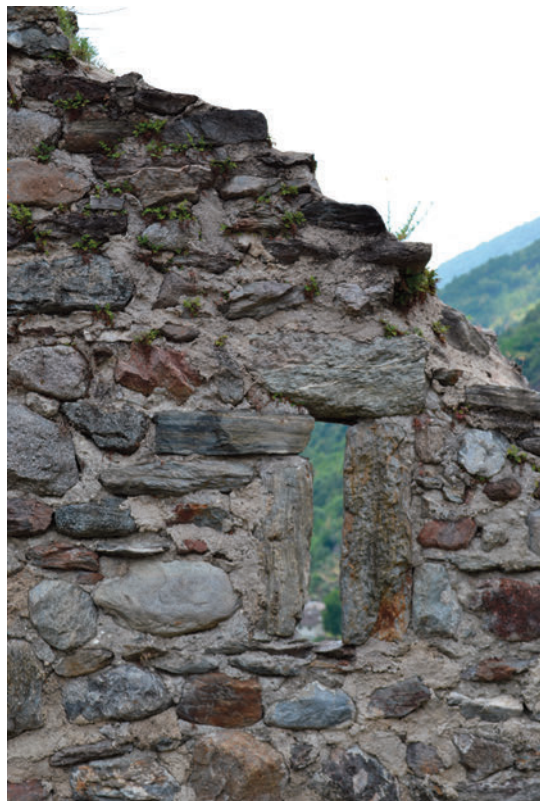
Fig. 4. Castello Vecchio, paramento esterno nord del vano H. Particolare dell'archibugiera in muratura e dei fori di alloggiamento, in rottura, pertinenti alle travi degli orizzontamenti interni al vano 1 (foto dell'Autrice).
