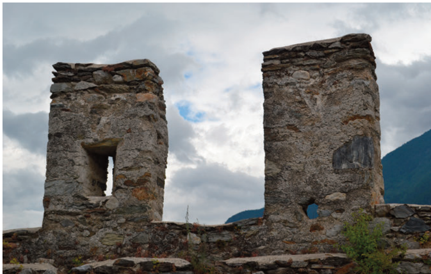
Fig. 15. Castello Nuovo, paramento interno ovest del circuito difensivo di periodo I, fase II. Particolare della trasformazione dei merli a coda di rondine in merli a sommità quadrata (foto I. Zamboni).
