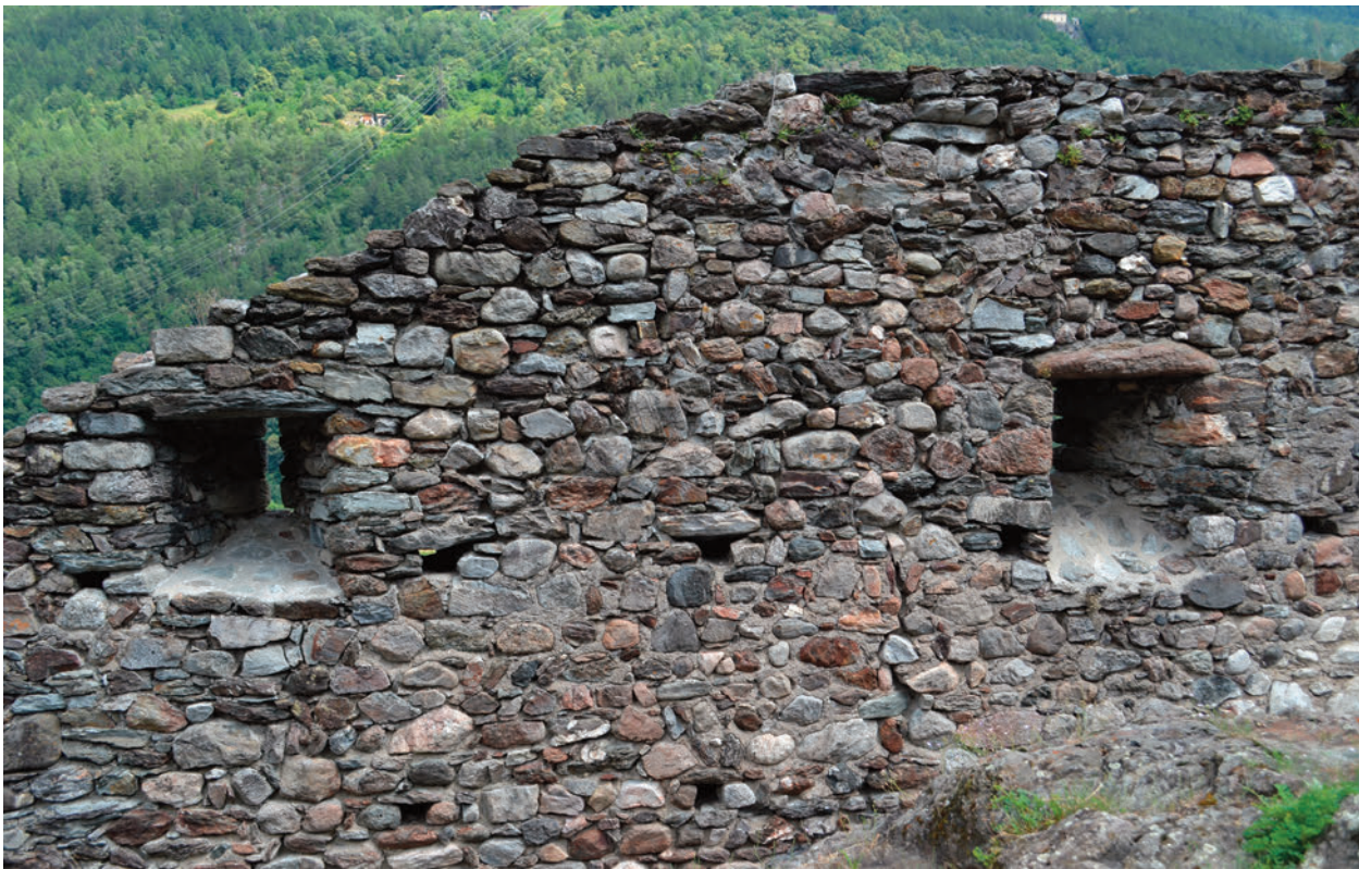
Fig. 3. Castello Vecchio, paramento interno ovest della cinta difensiva di periodo I. Particolare delle feritoie in fase con la muratura (foto I. Zamboni).
