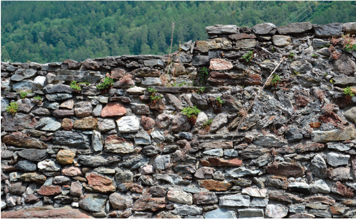
Fig. 2. Castello Vecchio, paramento interno ovest della cinta difensiva di periodo I. Particolare della tessitura muraria con alcuni elementi inclinati a 45° (foto I. Zamboni).
