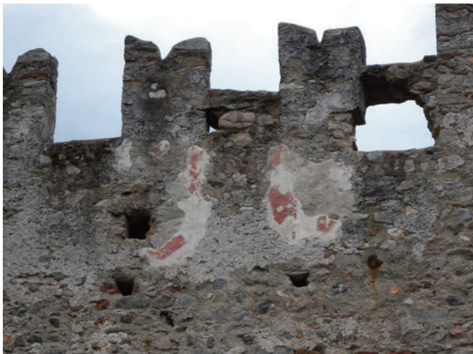
Fig. 12. Castello Nuovo, paramento esterno est del circuito difensivo di periodo I, fase II. Particolare dei lacerti di intonaco finito a frattazzo con decorazioni affrescate a stemma (foto dell'Autrice).
