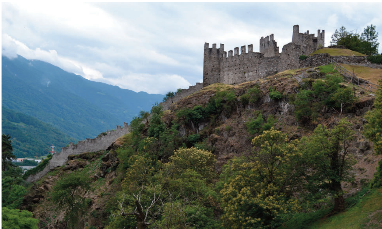
Fig. 13. Castello Nuovo, vista generale da nord della fortificazione con la chiesa (foto I. Zamboni).
