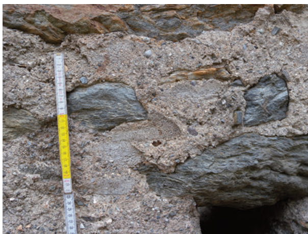
Fig. 10. Castello Nuovo, paramento interno ovest del secondo circuito difensivo di periodo I, fase II. Particolare di un'impronta di cazzuola impressa nella malta e coeva all'elevazione del muro (foto dell'Autrice).
