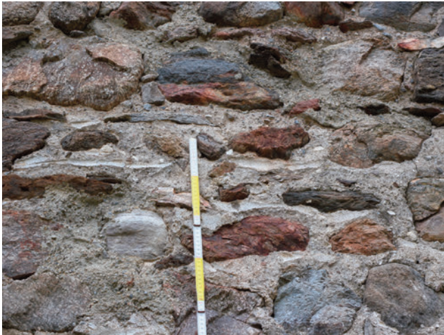
Fig. 6. Castello Nuovo, paramento interno nord del circuito difensivo di periodo I, fase I. Particolare della finitura dei giunti superficiali, riflucanti e liscciati a scivolo in senso orizzontale (foto dell'Autrice).
