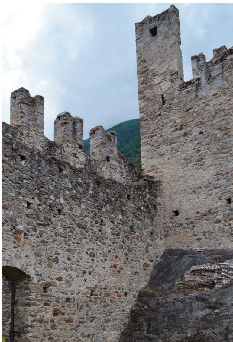
Fig. 8. Castello Nuovo, rapporto stratigrafico di posteriorità tra seconda cinta di periodo I, fase II, a sinistra, e primo perimetro difensivo di periodo I, fase I, a destra (foto I. Zamboni).
