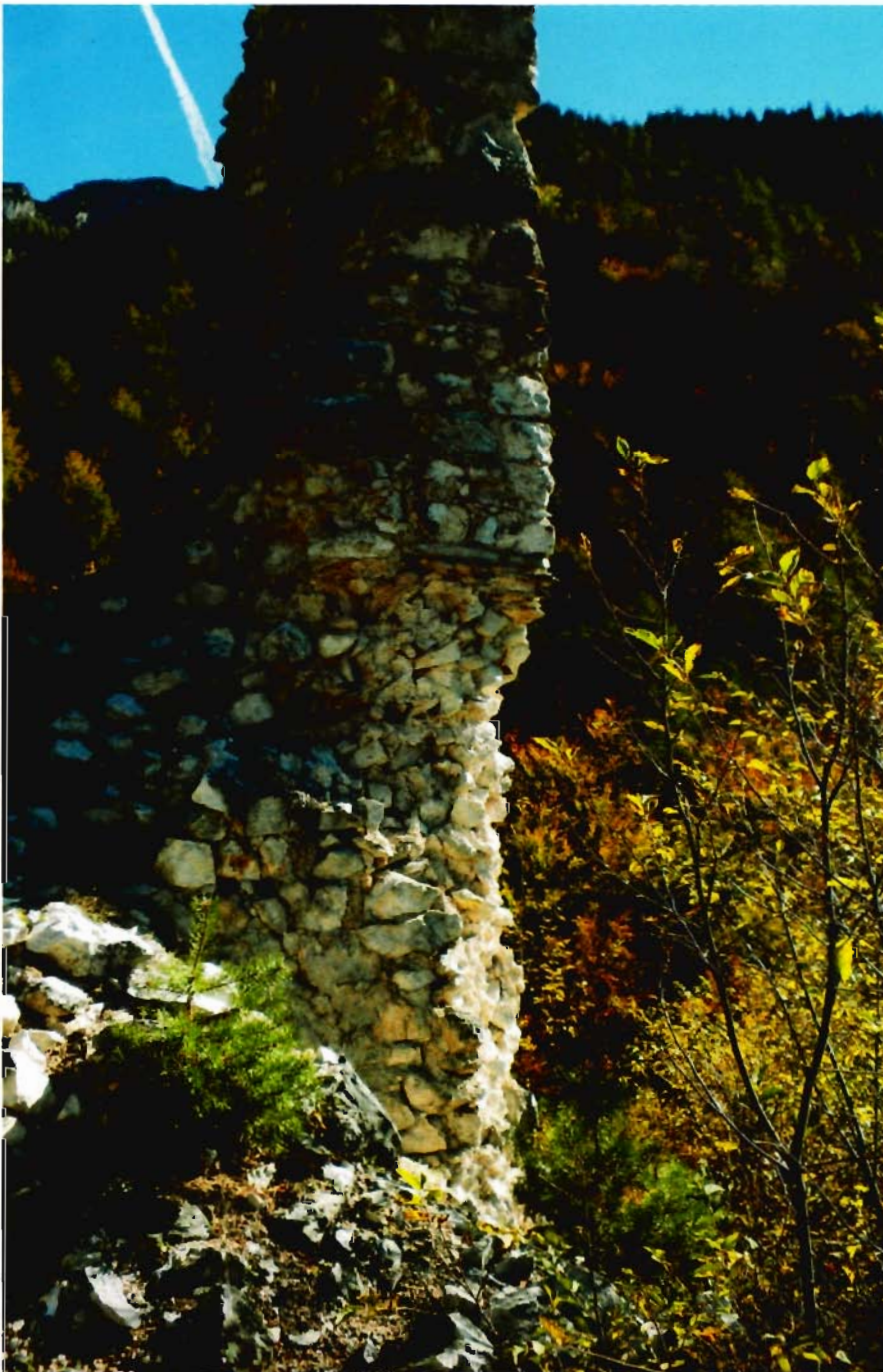
Fig. 9. Resti della muratura che delimitava a nord l'ambiente del nucleo D (foto I. Zamboni).
