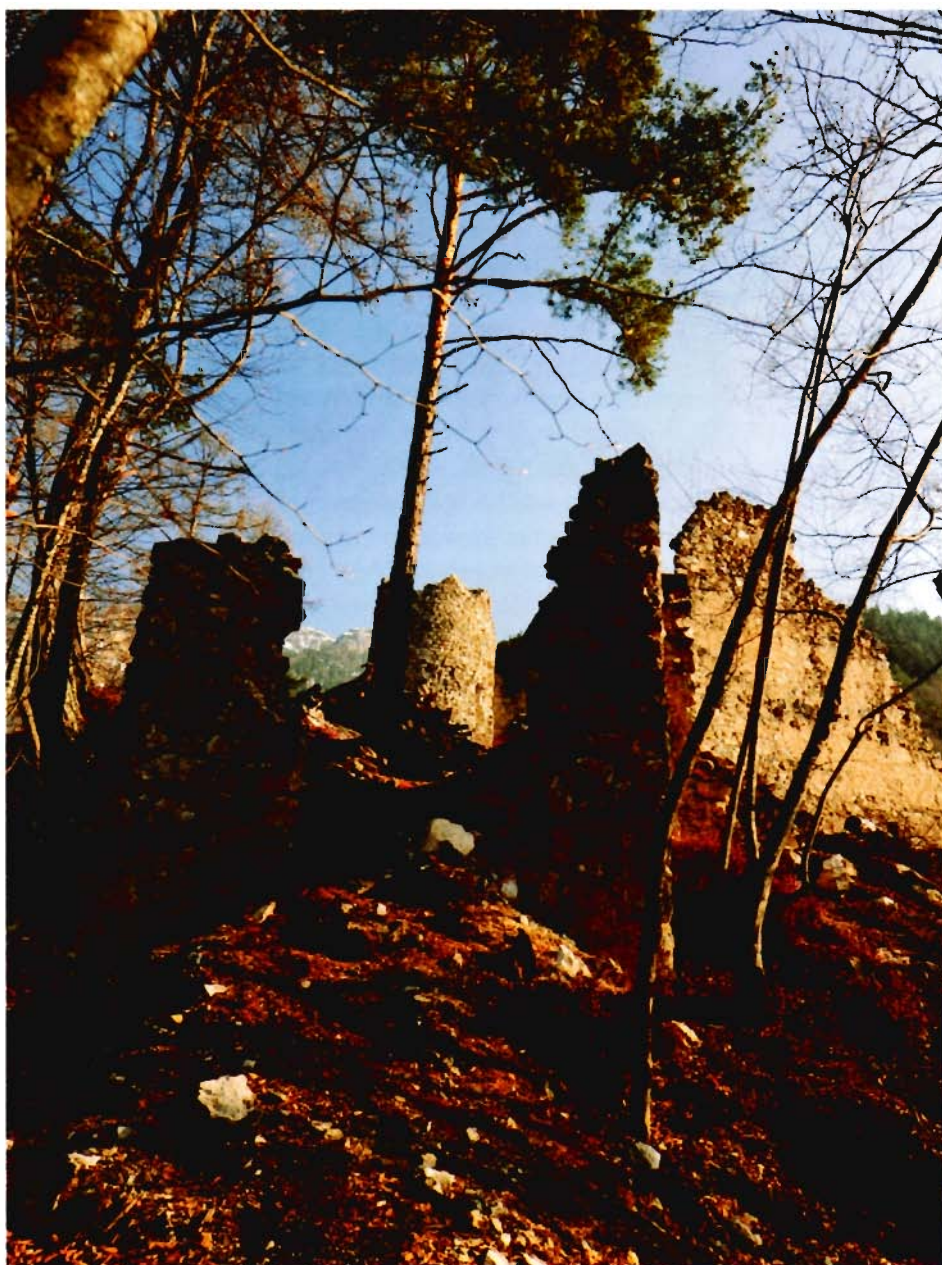
Fig. 3. Veduta del castello dal lato settentrionale: in primo piano i resti della torre scudata [foto FBK Fondazione Bruno Kessler].
