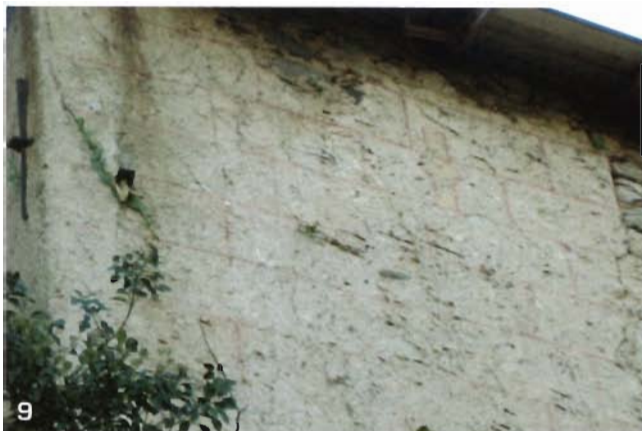
9. Particolare dell'intonaco a falsa cortina dipinta sul paramento O del corpo di fabbrica SO.
