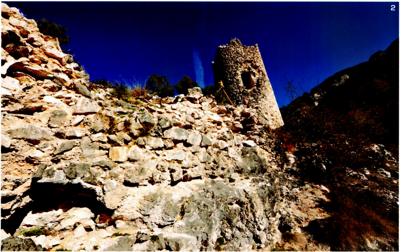
2. Tratto occidentale della prima cinta muraria.
