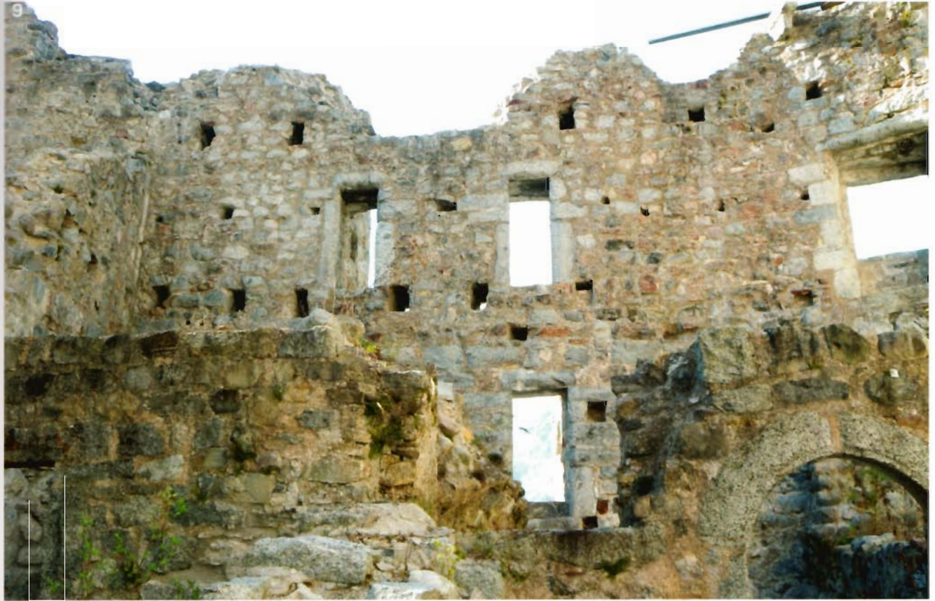
9. Vista generale degli ambienti dell'area N-O del nucleo fortificato (periodo III)
