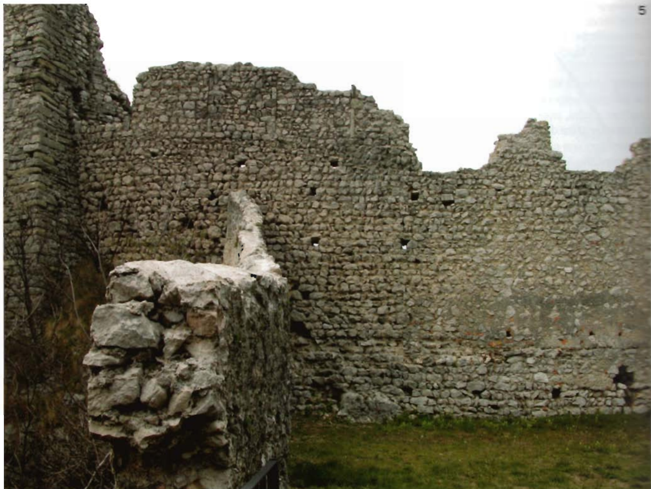
5. Vista da E della cinta esterna [US 1009].
