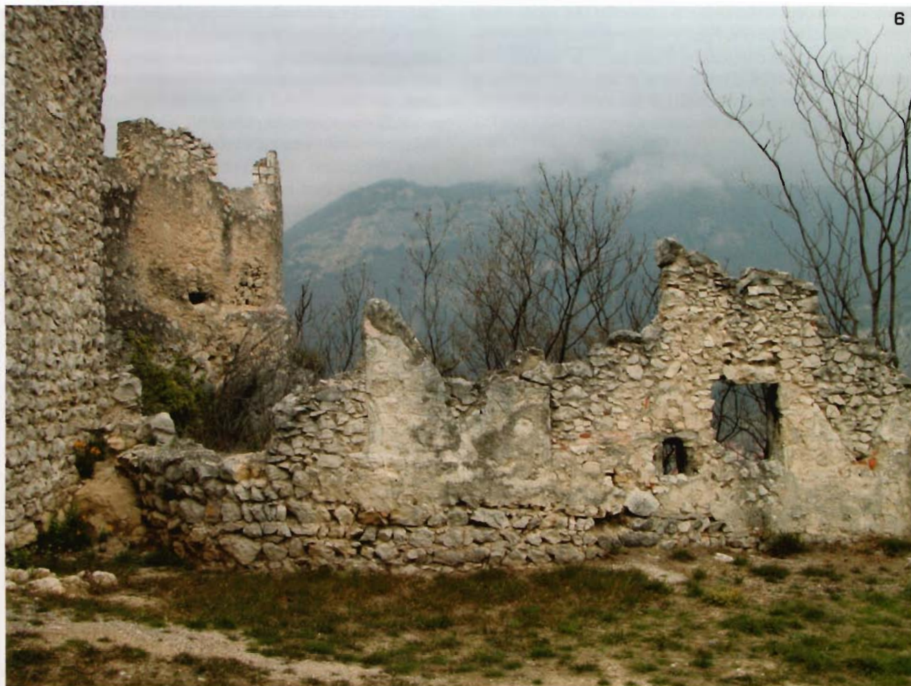
6. Vista interna verso N del rondello E con grande merlatura a coda di rondine.
