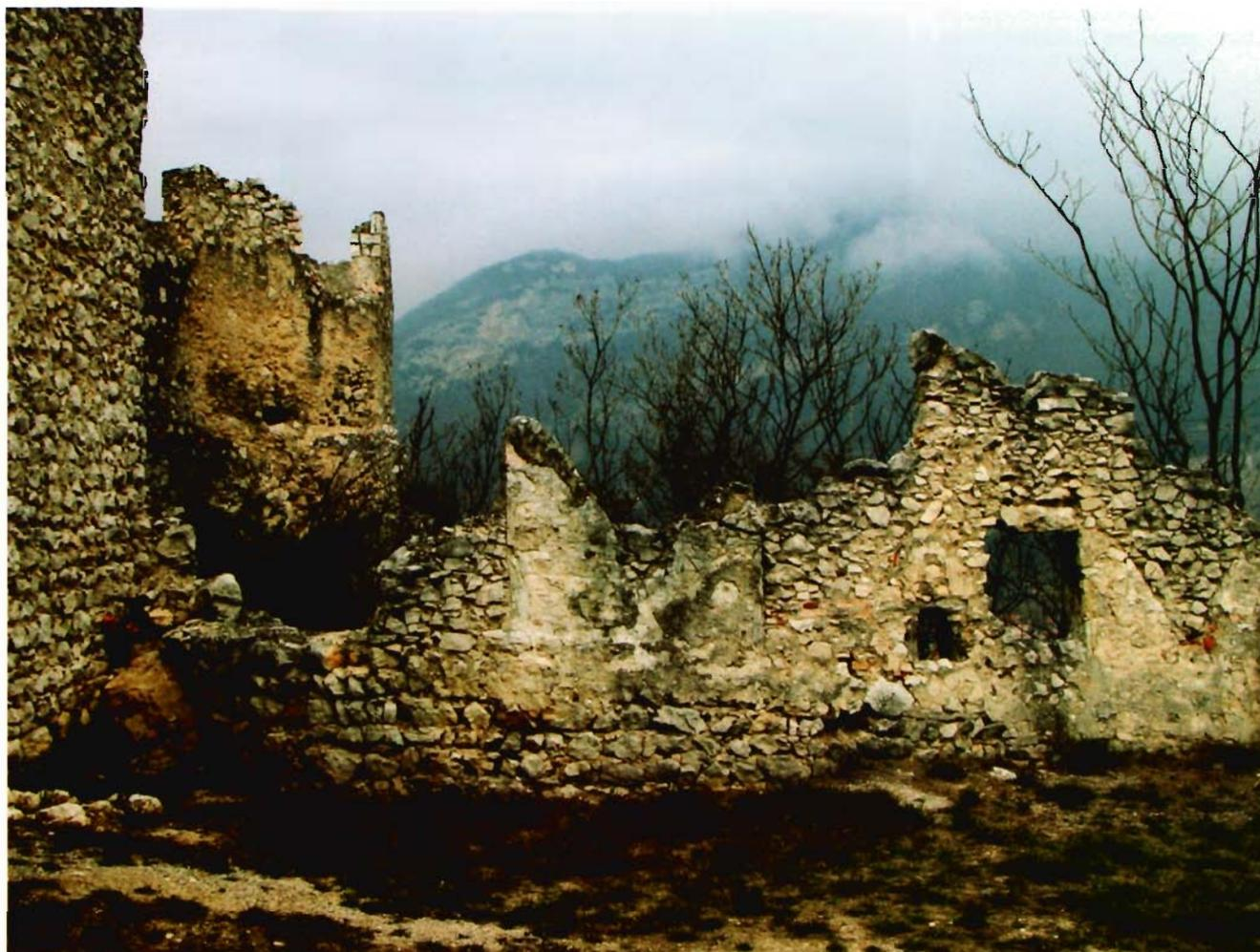
N [US 1014] con due merli a coda di rondine [EA 118-119, fig. 11] mentre verso S nella muratura [US 1010] si leggono in fase i resti di un merlo a coda di rondine [EA 132] inglobato nella successiva sopraelevazione della struttura muraria.
