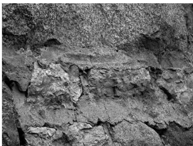
11. Particolare con impronta a cazzuola (a punta arrotondata) dei giunti di malta della muratura interna, 4° livello, 1ª fase di cantiere, periodo I
