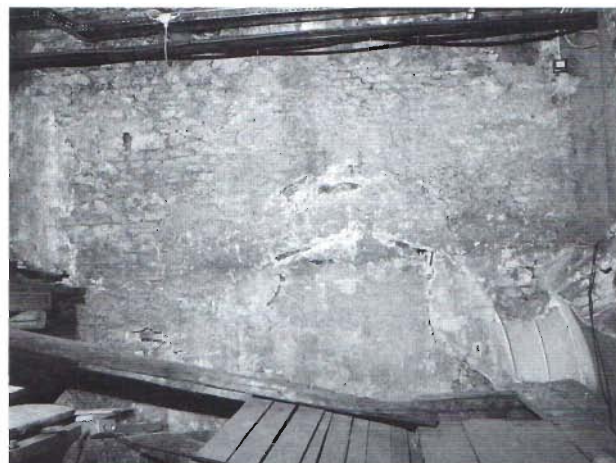
Fig. 7 – Dettaglio parete sud, porzione inferiore.
