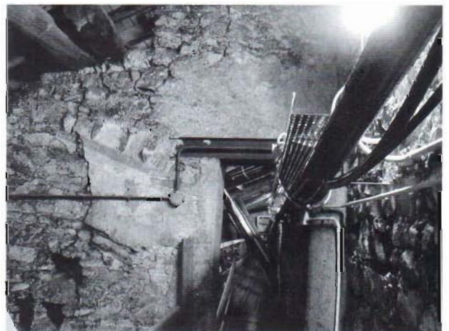
Fig. 5 – Particolare parete ovest lato esterno verso ambiente C.
