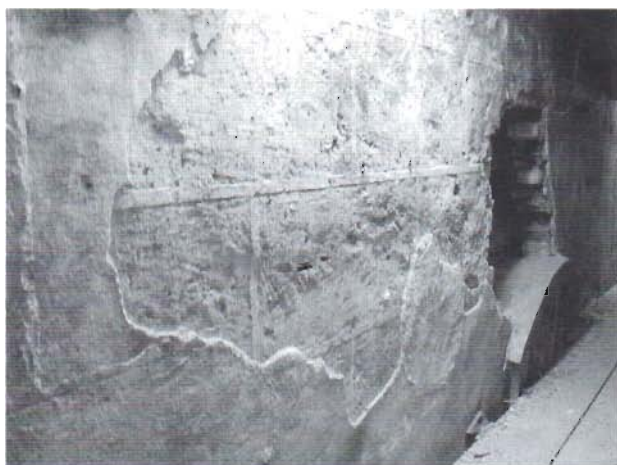
Fig. 18 – Intonaco a finti blocchi presente sulla muratura nord dell'ambiente D.
