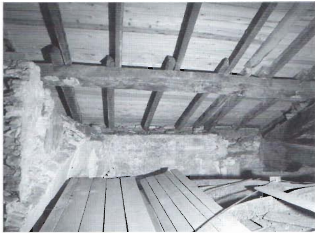
Fig. 10 – Vista dei resti murari della parete nord.
