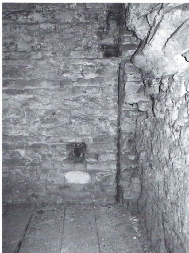
Fig. 17 – Addossamento della muratura ovest della cappella di S. Giorgio alla muratura sud, angolata sud e resti del collegamento voltato con la chiesa di S. Agostino .
