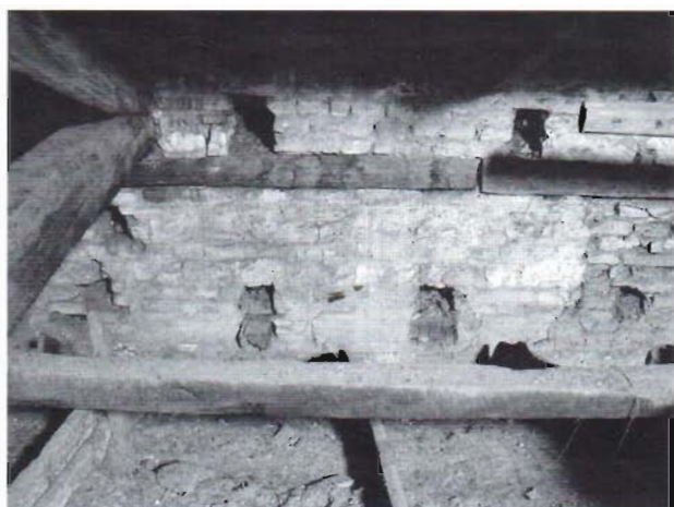
Fig. 14 – Dettaglio della muratura sud dell'ambiente B.
