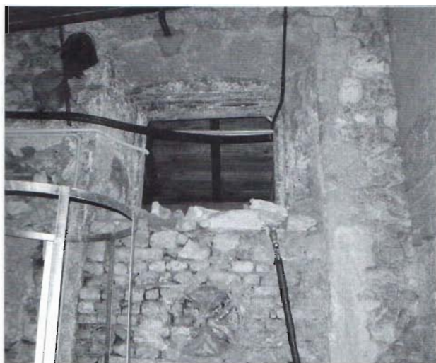
Fig. 16 – Apertura tamponata sulla parete sud dell'ambiente C.
