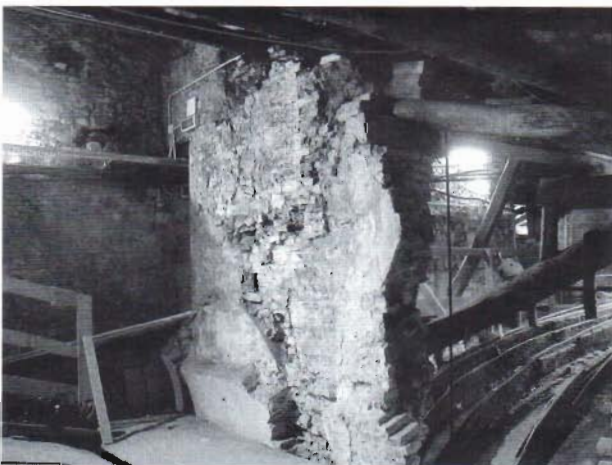
Fig. 4 – Vista della parete ovest: a) lato sinistro, b) lato destro.
