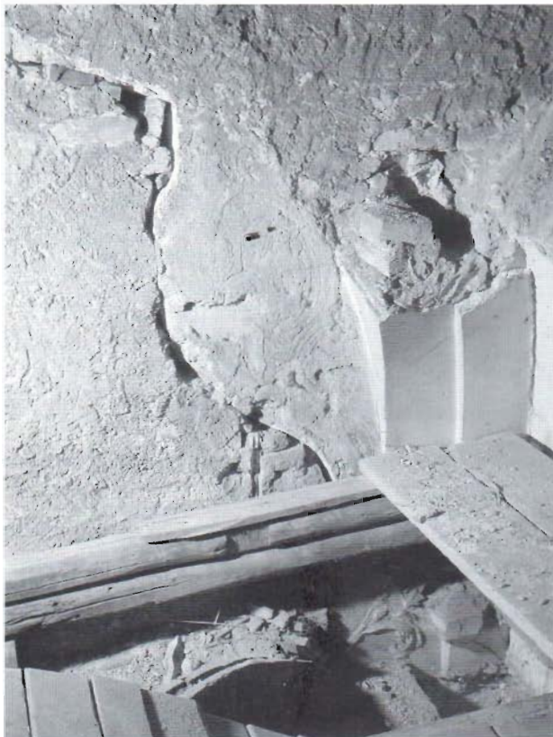
Fig. 8 – Particolare dei resti della decorazione a stucco della chiesa sei-settecentesca.
