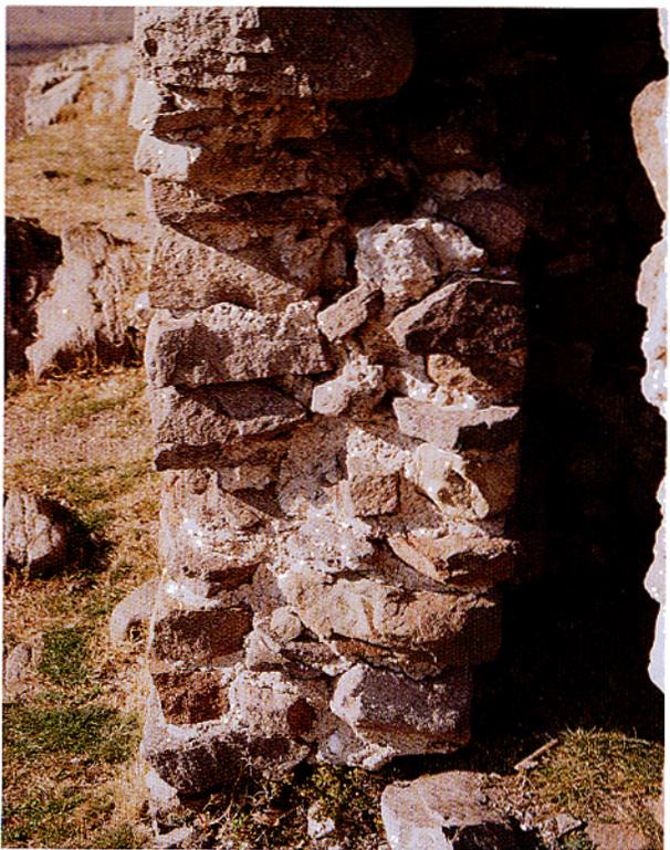
esterni e un riempimento realizzato con elementi lapidei di piccole dimensioni, malta e qualche raro elemento in cotto (mattoni dello spessore di cm 4).
