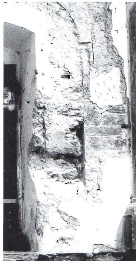
Fig. 2. Parete Sud: prospetto interno dopo la rimozione degli intonaci moderni. Particolare con resti del portale d'ingresso medievale.
