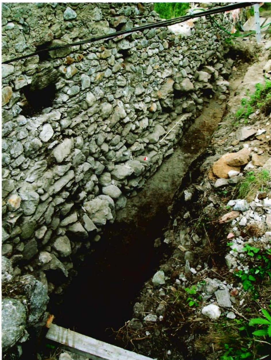
Fig. 6. Nucleo G, prospetto interno E, trincea di scavo, anno 2005 (foto ASBAATn - G. Bellosi).
