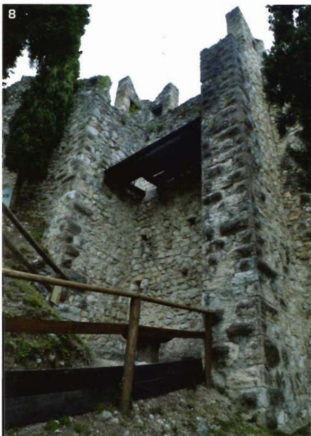
8. Torre scudata in fase con la cortina esterna S.
