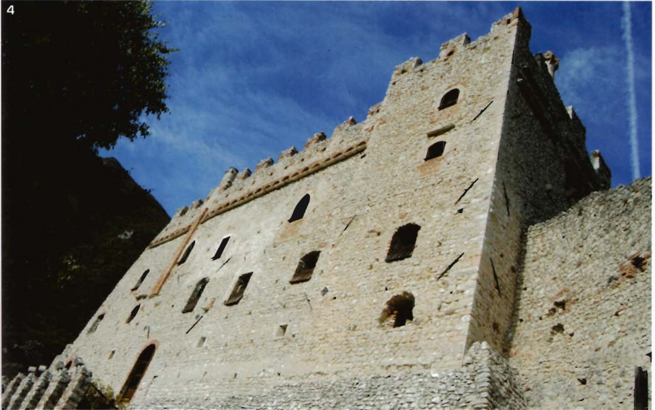
4. Vista generale del "palazzo baronale" da SE.
