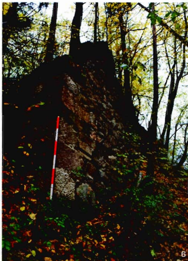
6. Vista da E della porzione S del sistema di ingresso.
