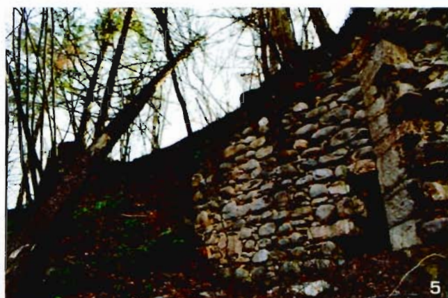
4. Perimetrale esterno O del nucleo abitativo a pianta rettangolare.
