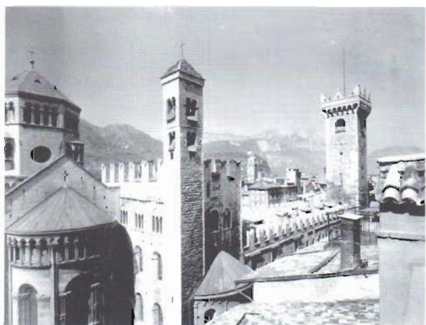
fig. 10 – Vista sud-est della Torre con l'avvenuta demolizione del collegamento esterno tra palazzo Pretorio e la Torre di Piazza (1964) (Fondo Fratelli Pedrotti – Ufficio Beni Storico Artistici – Sezione Fotografia – Patrimonio).
