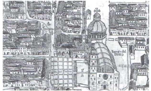
fig. 4 – Cartografia della città di Trento eseguita da A. Vavasore (1562-1563): dettaglio della torre e della loggia (Vienna – Österreichisches Staatsarchiv).
